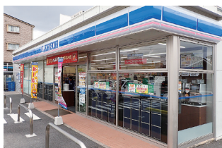
第2図 ガラス面の設置状況
