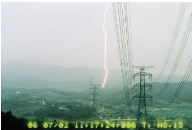
第4図 架空地線損傷表示器を動作させた雷撃 (2006年7月2日 11:17:24)
