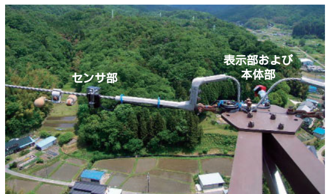
第3図 架空地線損傷表示器 (上図：装置外観、下図：取付状況)
