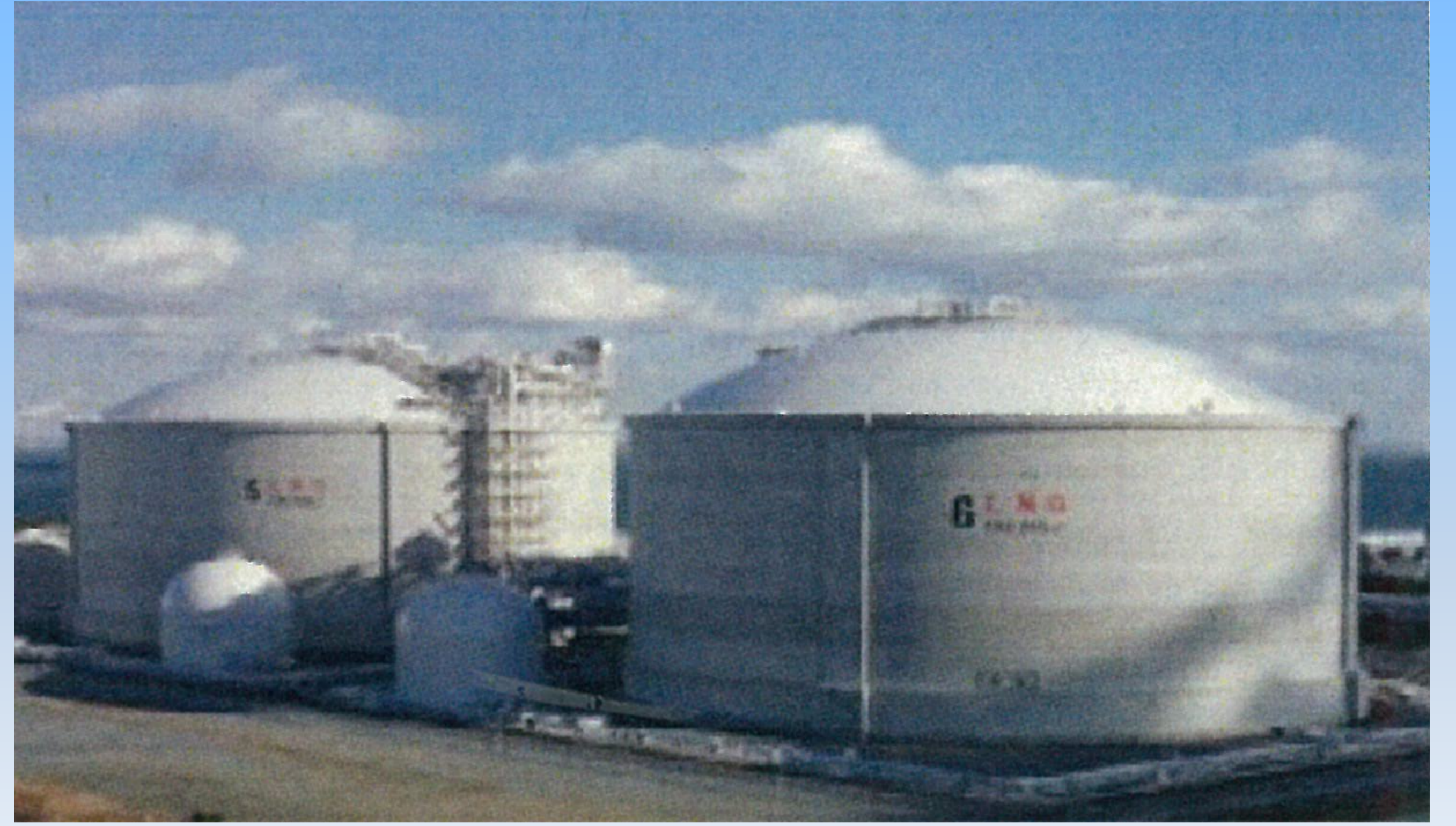
LNGタンク（容量18万m 3 /基）
