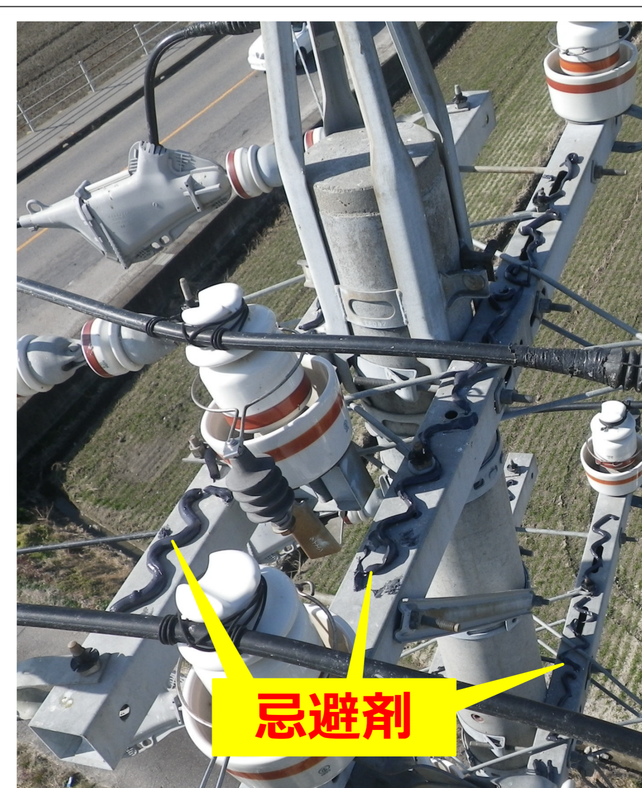
電力設備への塗布
