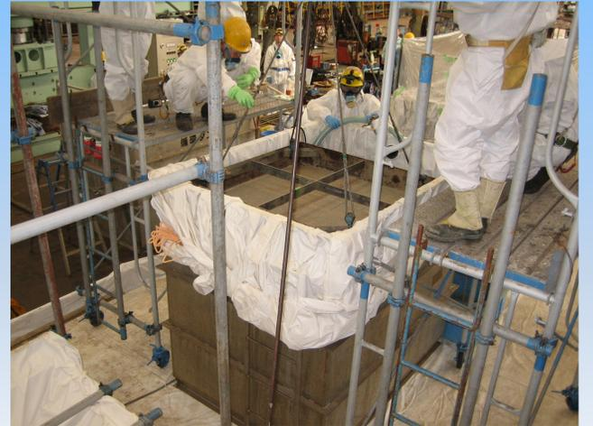
脱硝触媒の化学洗浄
