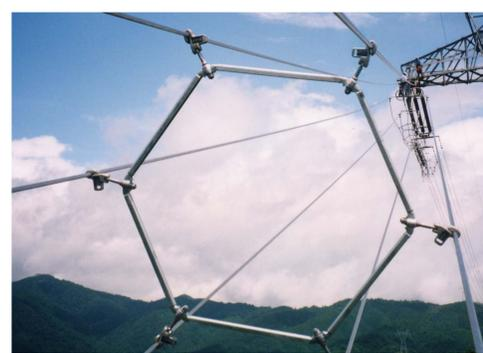
500kV越美幹線スパーサ(導体間隔1.2m)
