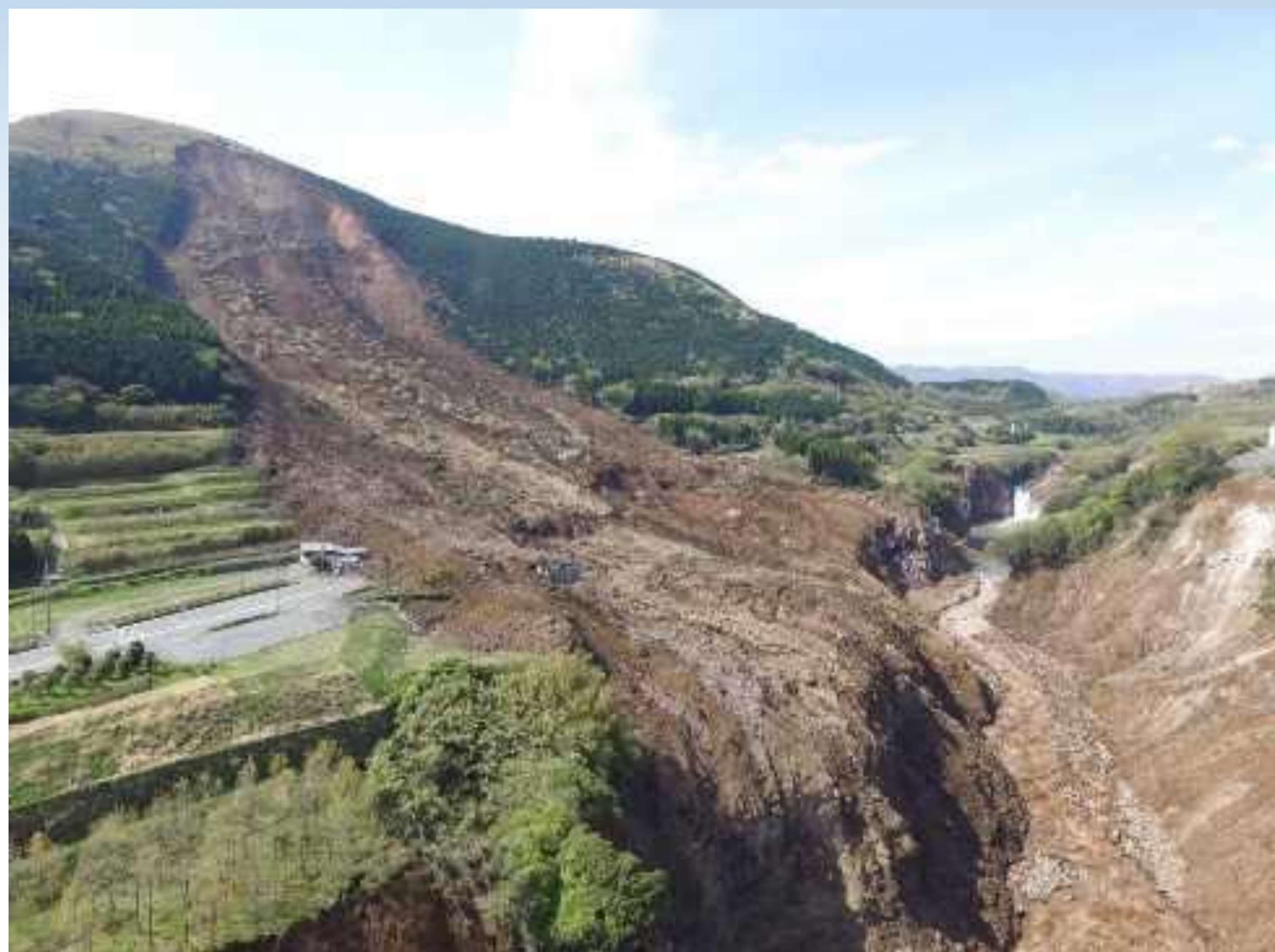
大規模崩壊事例 (熊本大橋地区、国土交通省HPより)
