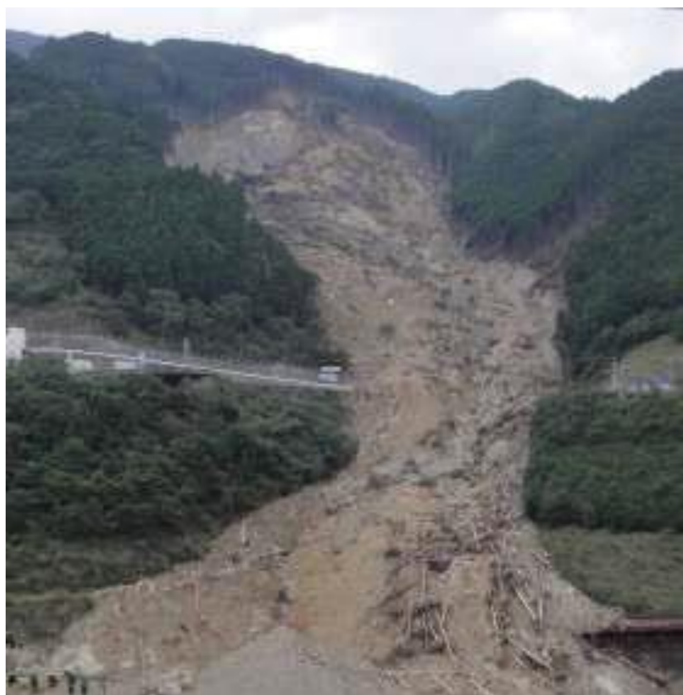
崩壊地の全景 (土木学会平成23年台風12号土砂災害 調査報告書より)
