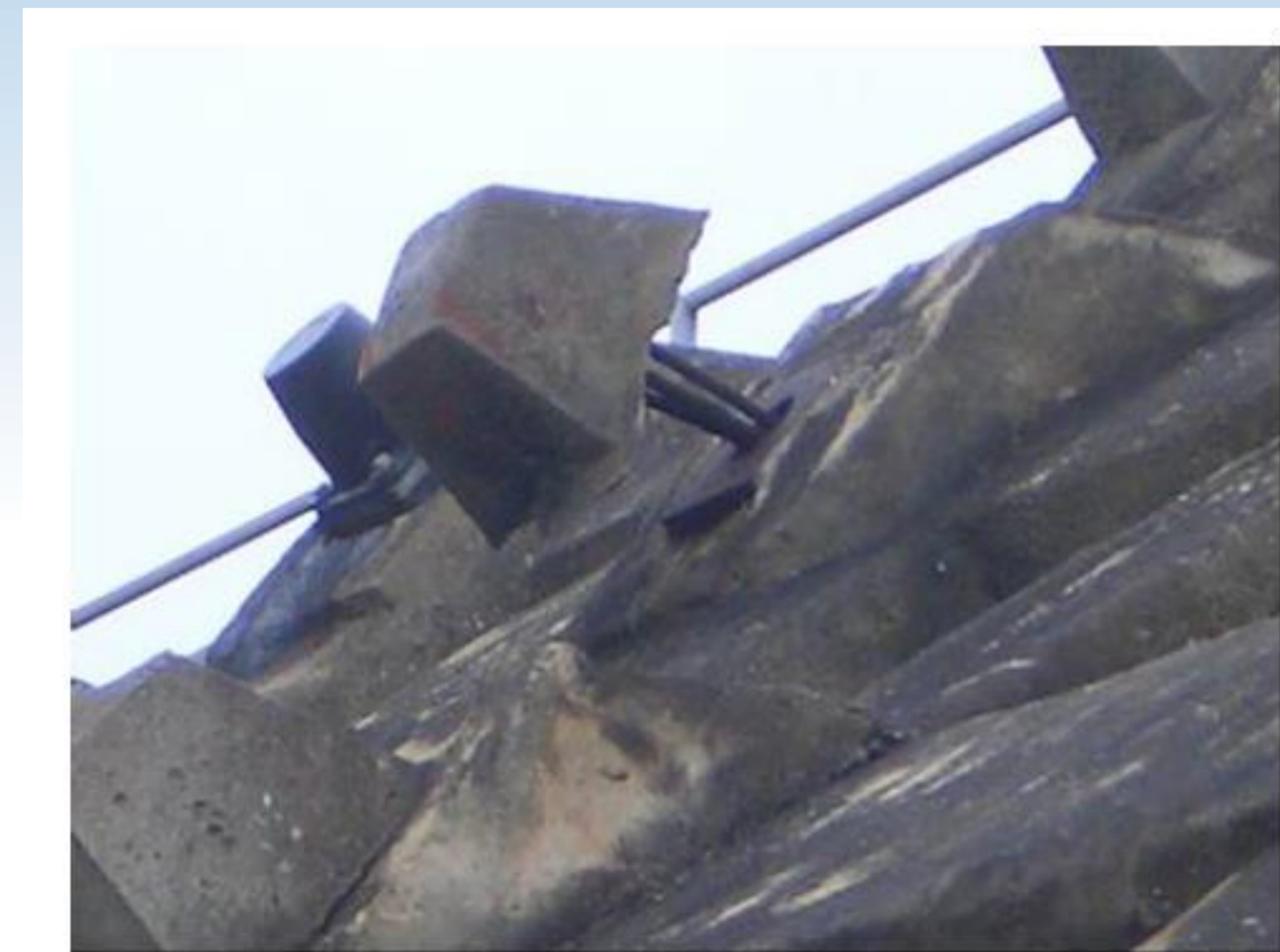
鋼より線タイプ より線の浮き上がり
