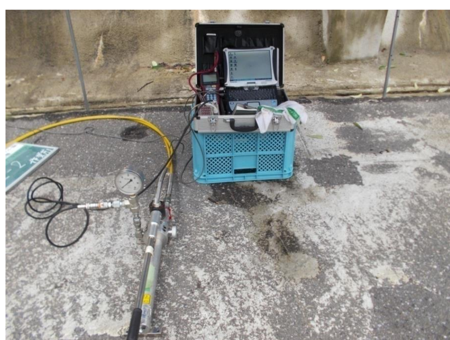
油圧ポンプ・モニター用PC
