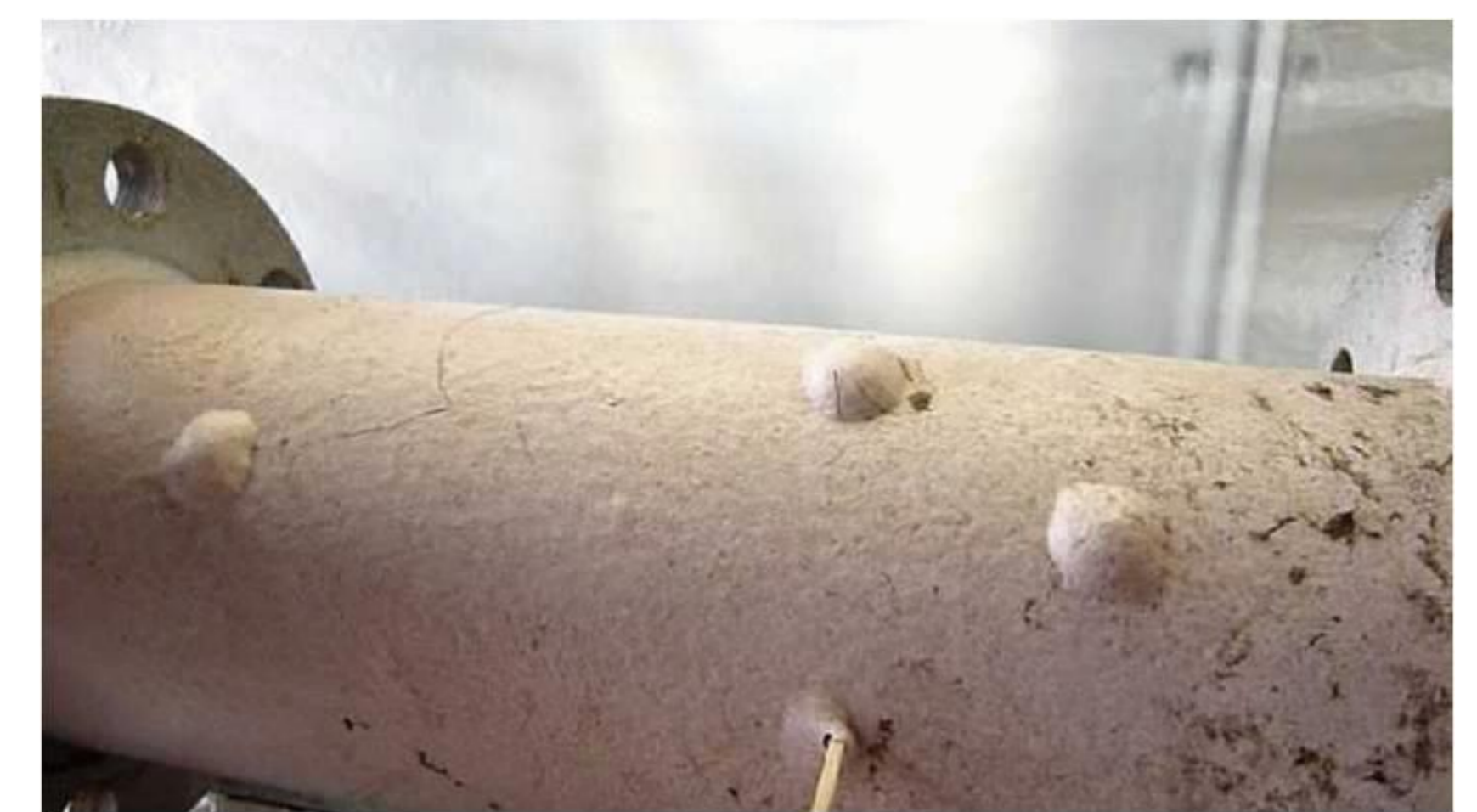
図-4 加圧状態からの空気漏れ
