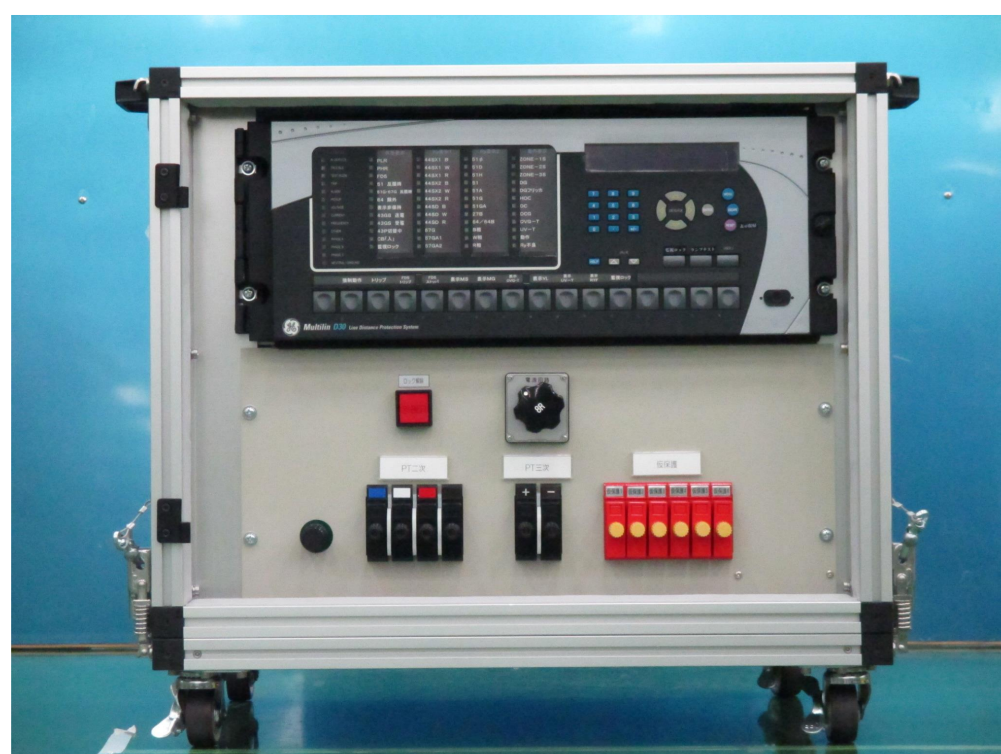
仮リレー箱1 (メインリレー箱)
