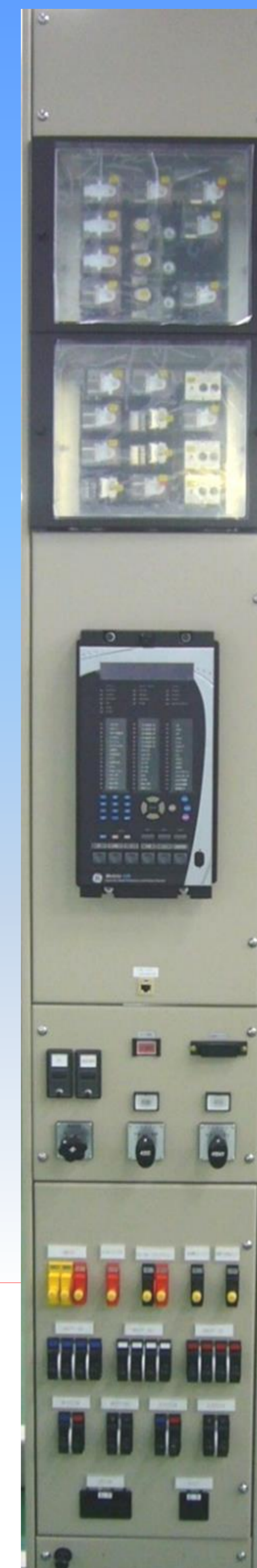
電力用並列コンデンサ 保護継電装置
