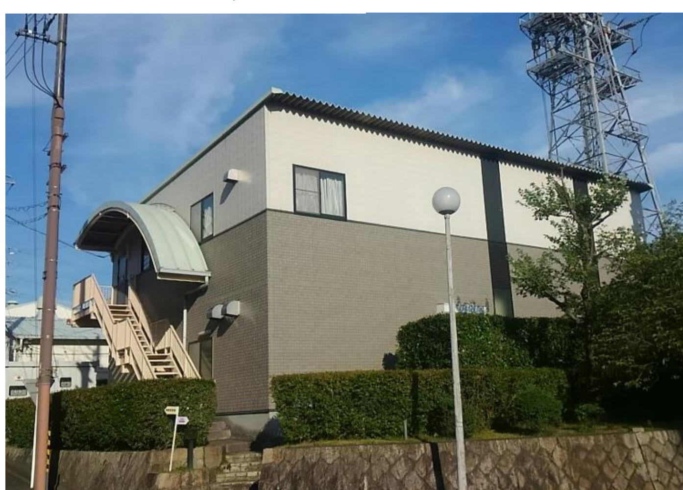
西側の窓に採光フィルムを設置
