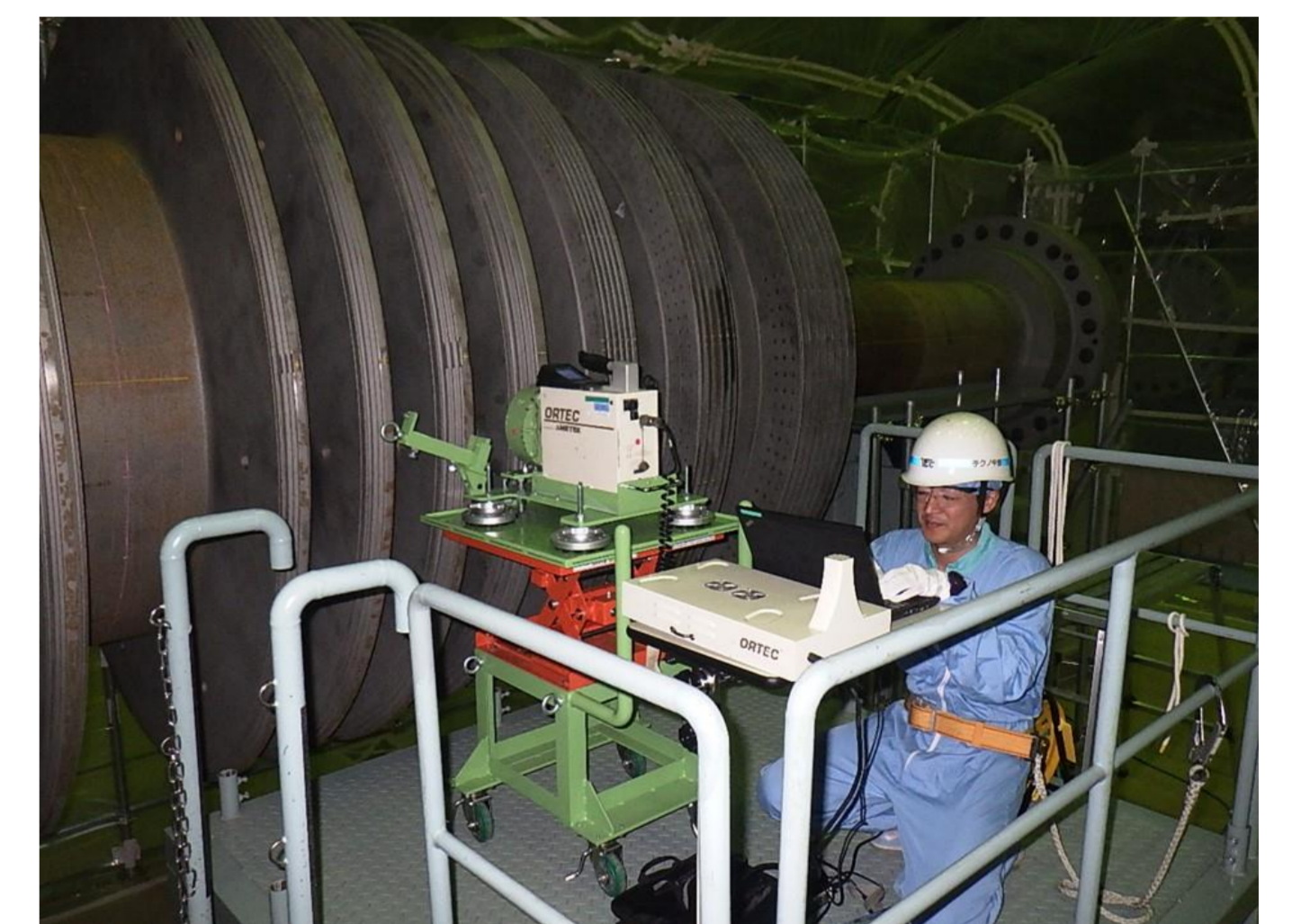
②タービンロータを測定している様子
