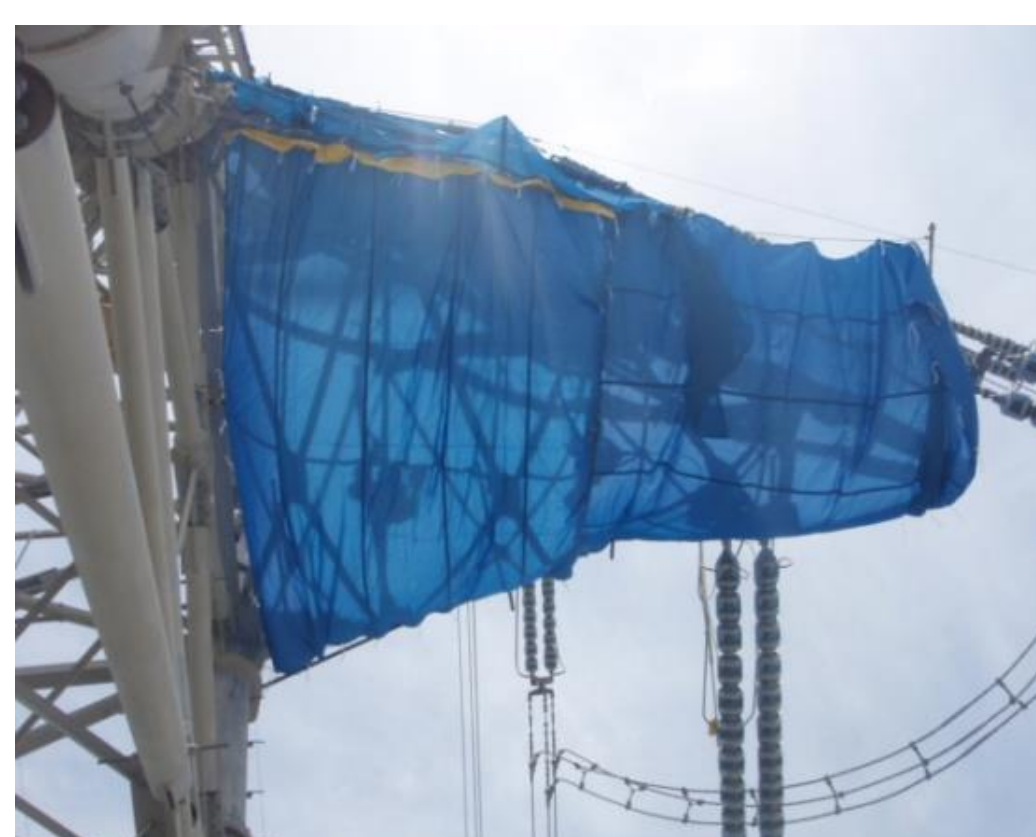
鉄塔塗装時の施工例（下から撮影）
