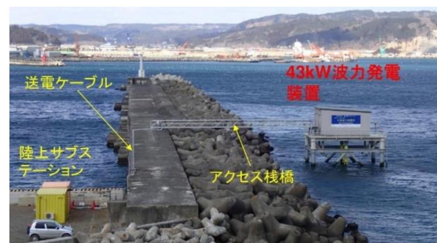
久慈波力発電所
