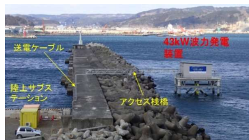
久慈波力発電所
