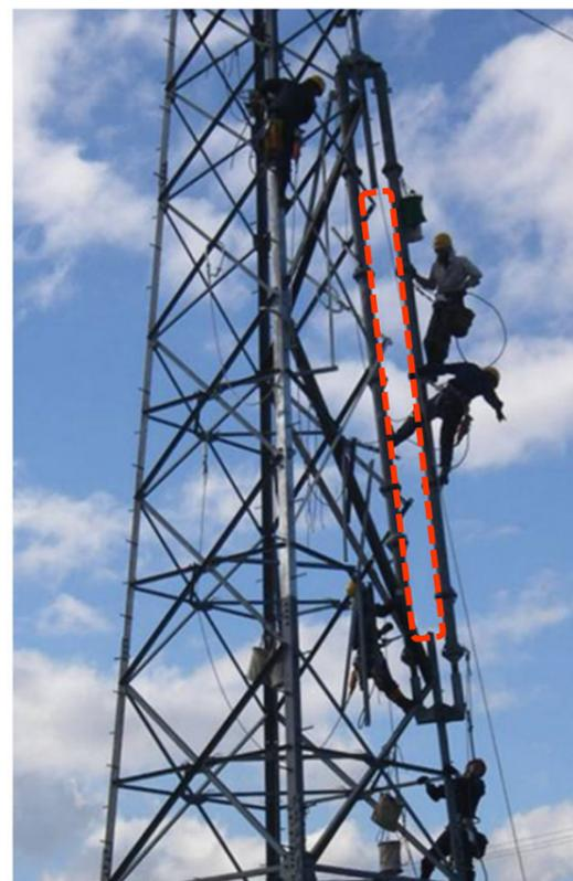
腐食した支柱材は取り外して取り替えることが可能です。勿論，設備改修による既設計条件から条件変更に伴う部材改造にも対応できます。
