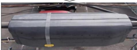
光クロージャカバーの補修例
