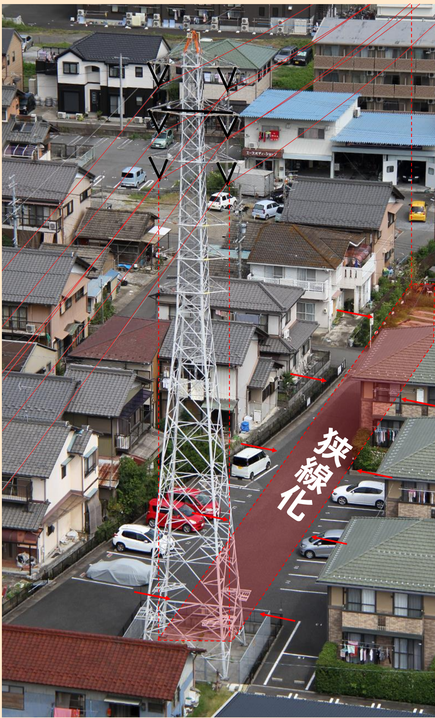
狭線化（本線用）
