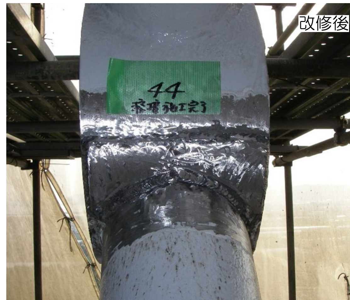
添え板の現場溶接による補強を実施
