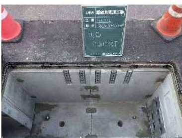
内面仕上げ完了
