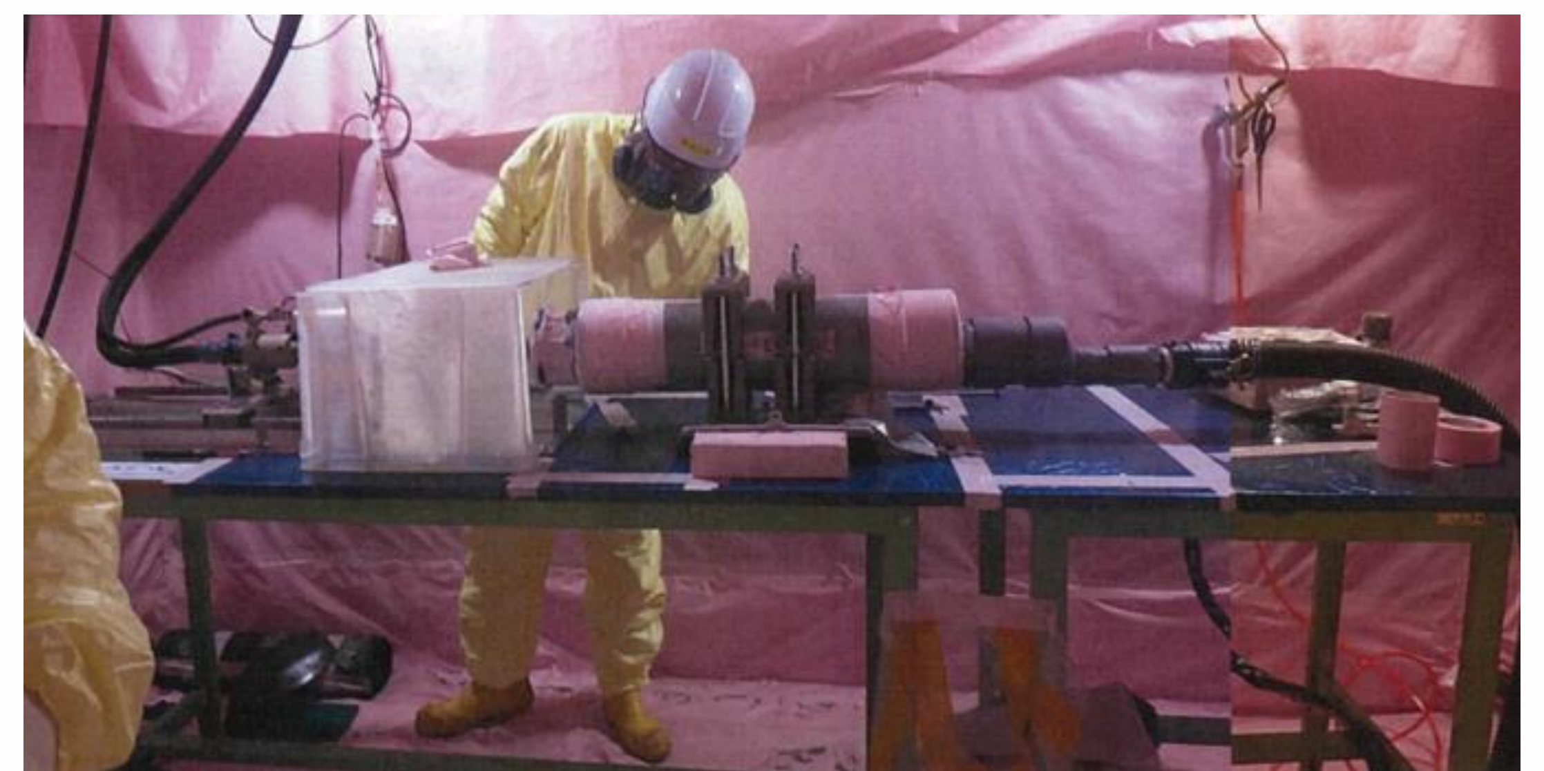
除染装置試作機の実証試験
