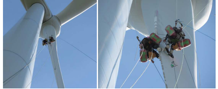
ロープワークによる風力発電設備点検の様子
