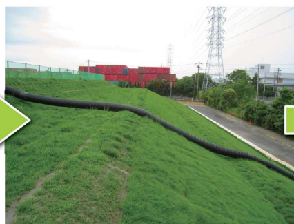
2017/7/14 施工後約3カ月
