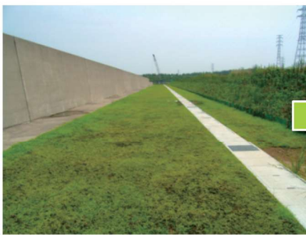
2013/8/8 施工後約1カ月目
