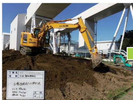
土壌改良状況
