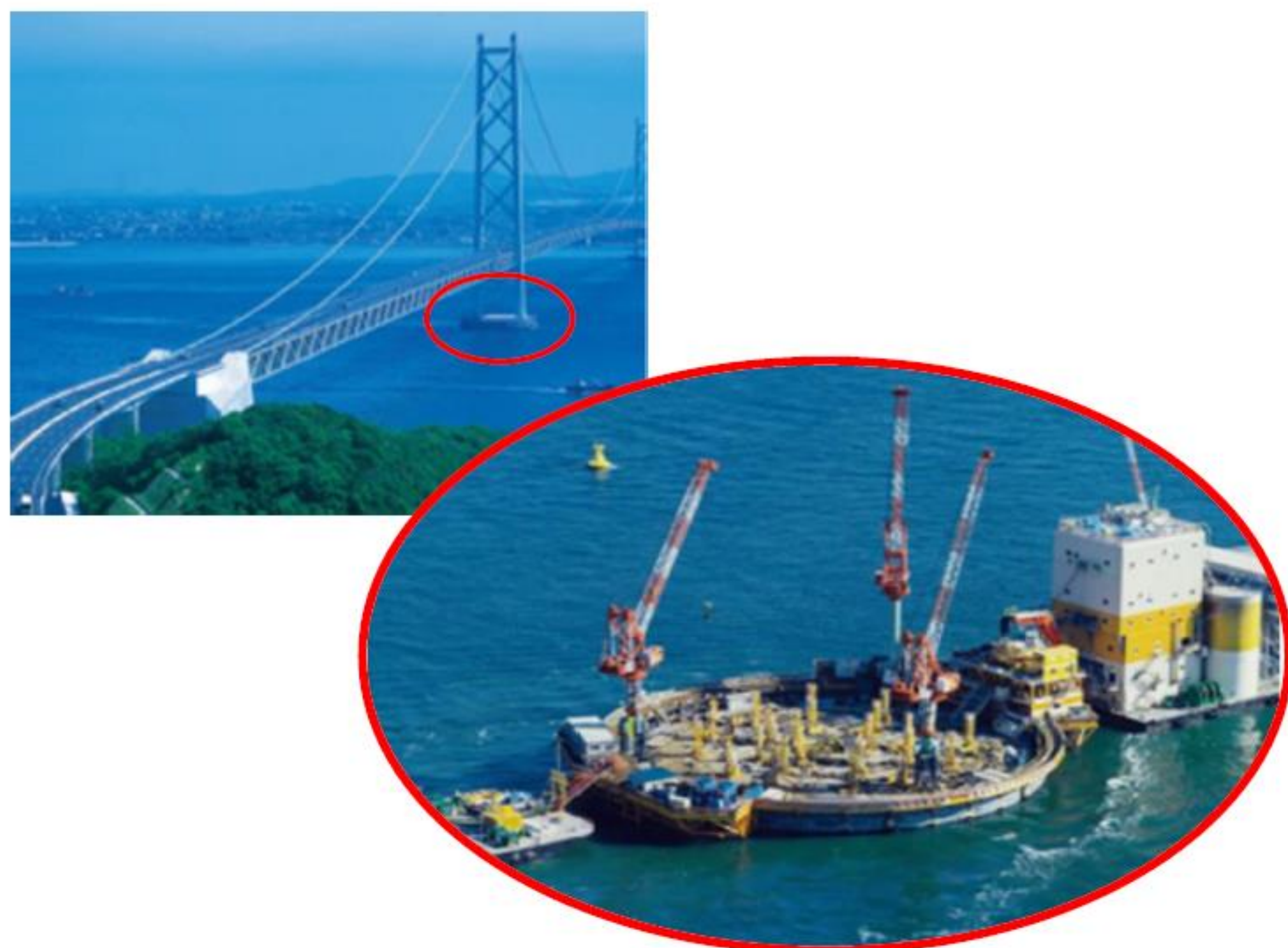
橋梁基礎の建設（明石海峡大橋）
