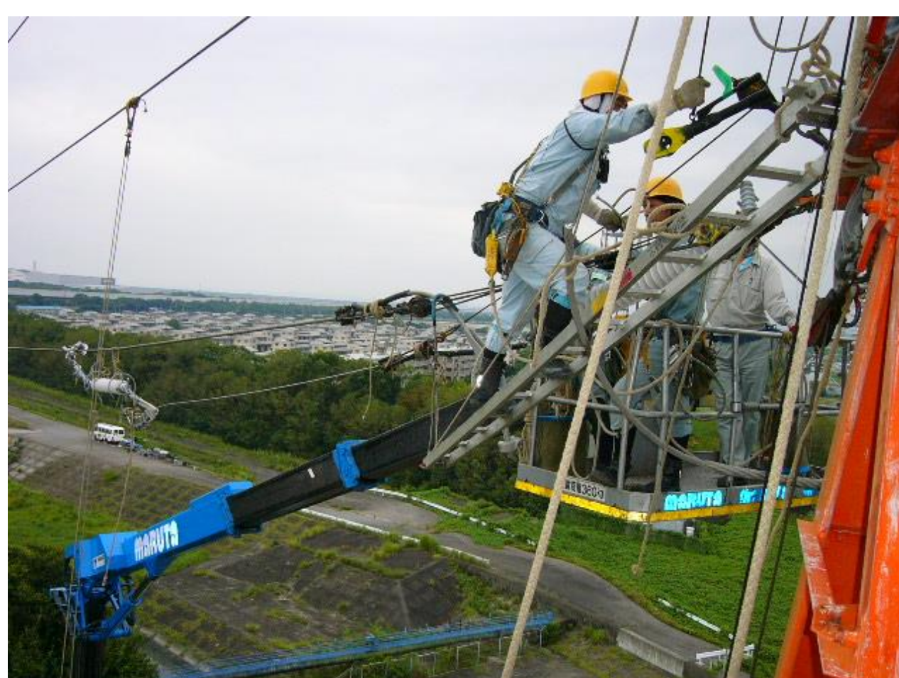
屋外塔上作業
