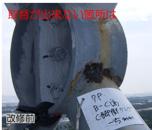
添え板溶接による補強
