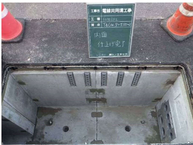
内面仕上げ完了
