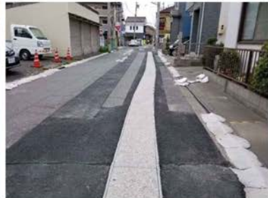
据付完了(As 舗装) (曲線部施工状況)
