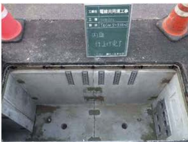
内面仕上げ完了
