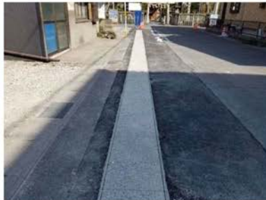
復旧完了(As 舗装)
