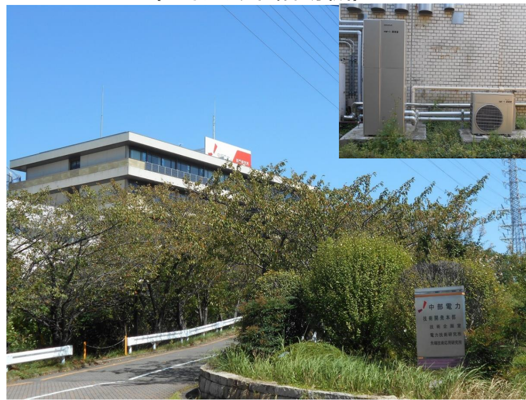
＜中部電力 技術開発本部食堂 （ハイブリッド給湯機）＞
