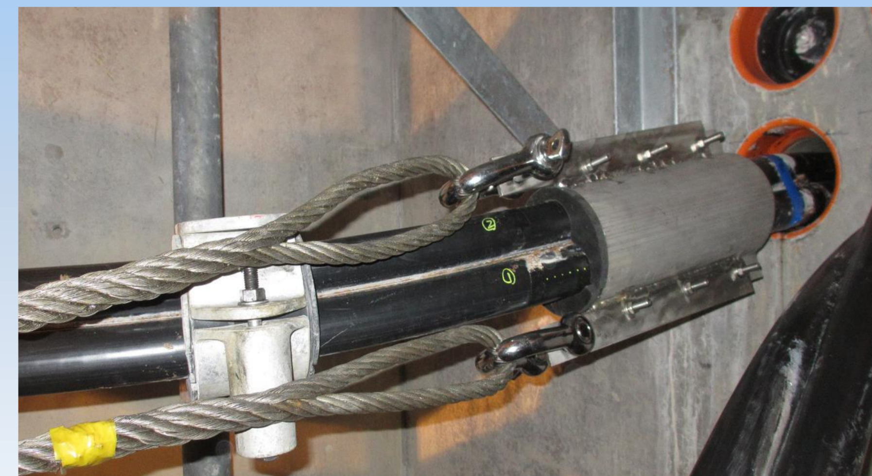
CVTケーブル引戻し装置使用状況
