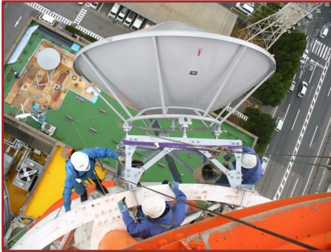
通信設備の構築
