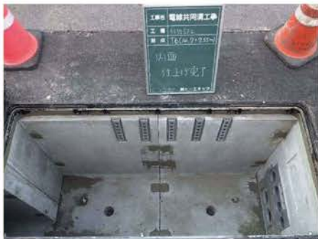
内面仕上げ完了
