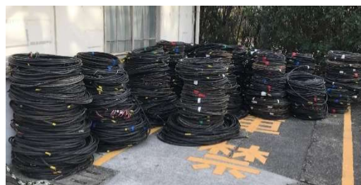
ケーブル布設
