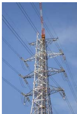
275kV東信新北信線建替工事 (耐張鉄塔→分岐鉄塔)
