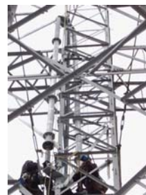
腐食した主柱材の取り替え
