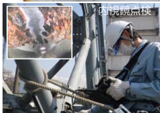
腐食の状況(色、表面の凹凸など)で劣化状況を推定します。
