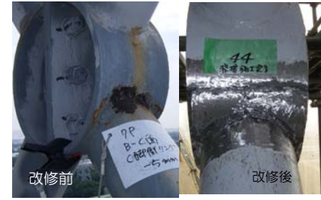
添え板溶接設置による補強
