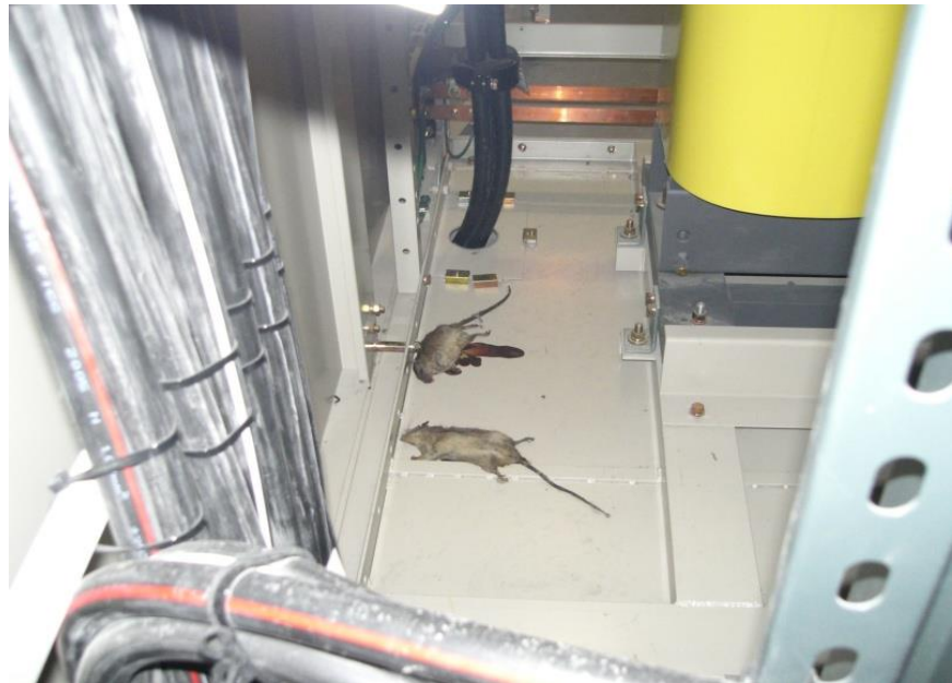
高圧充電部に接触したネズミの死骸
