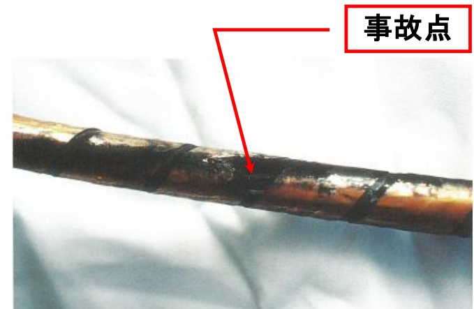
水トリ劣化による事故点
