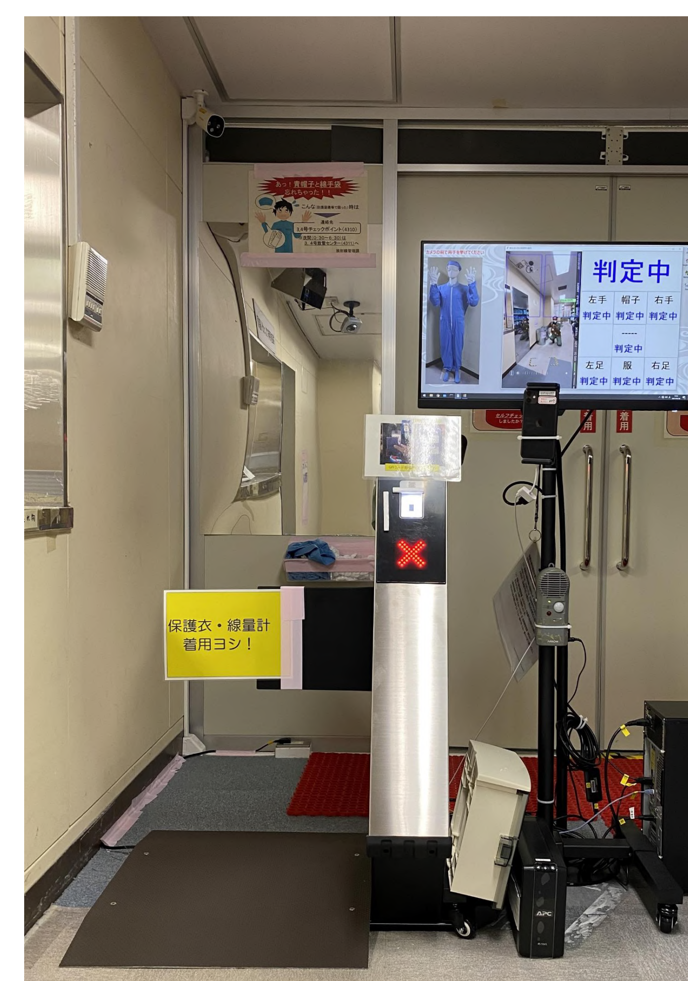
②発電所に導入したA I ゲート
