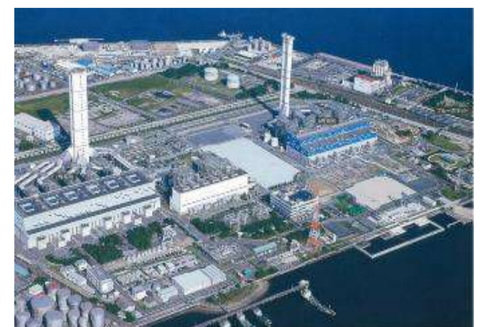
GTCC火力発電所
