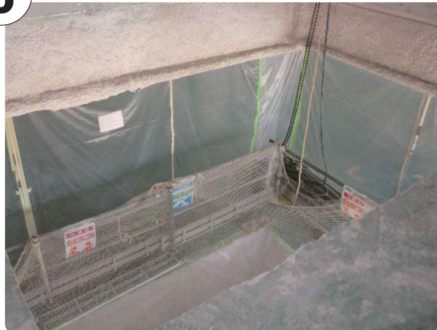
5 3階床スラブ開口完了
