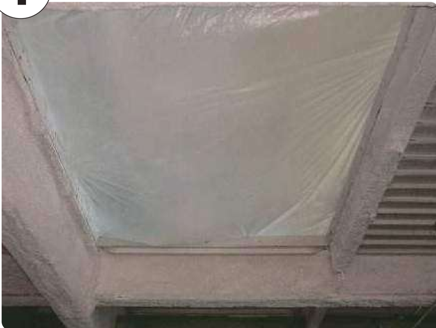
1 3階床スラブ下の養生
