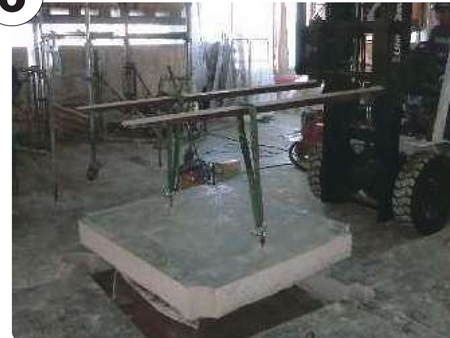
6 開口完了後、場外で小割
