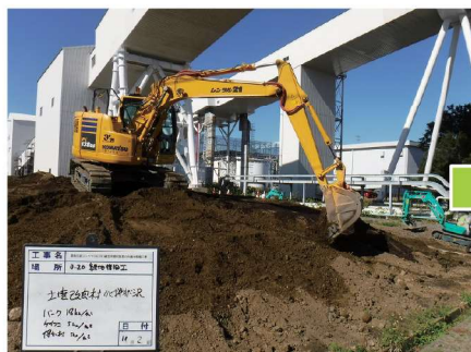
土壌改良状況
