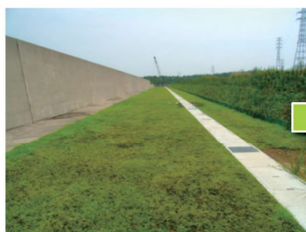
2013/8/8 施工後約1カ月目
