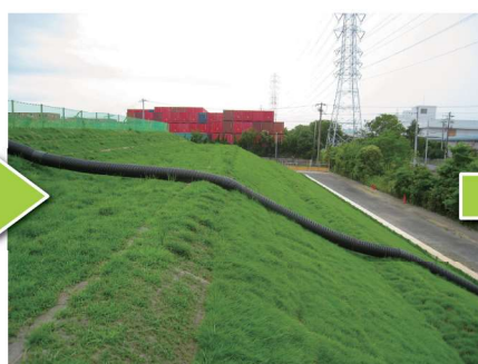
2017/7/14 施工後約3カ月
