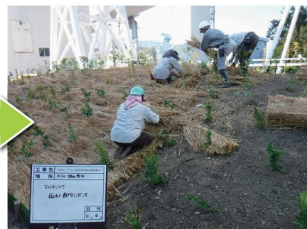
ワラマルチング敷設状況
