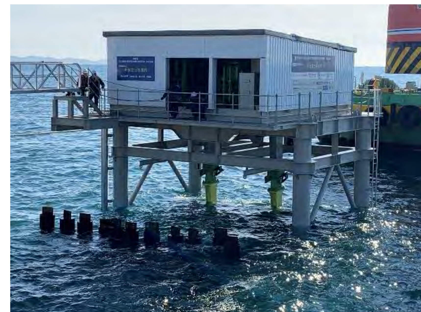
平塚波力発電所
