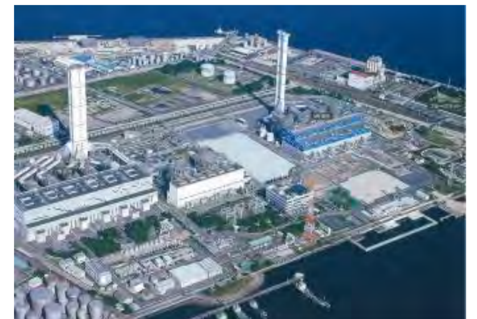
GTCC火力発電所
