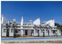
受変電用プラント工事 Installation of electrical substations
