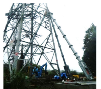
三又サポートによる基礎材・基礎体の改修
