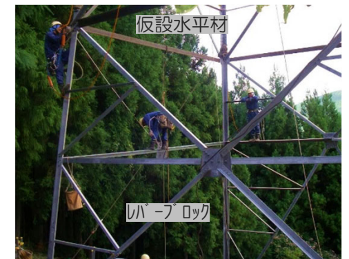
送電鉄塔のプラット結構化による部材取替
