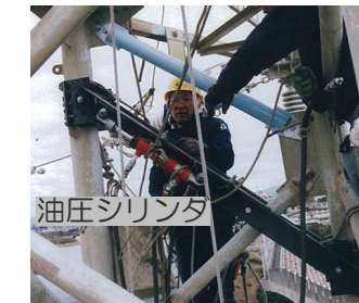
鋼管鉄塔の伸縮機能付仮設装置による部材取替
