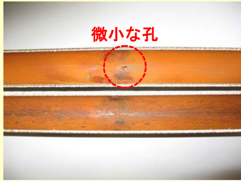
孔が確認された伝熱管内表面写真
