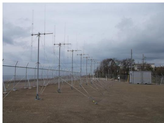
設置したVHFレーダーのアンテナおよび観測所
