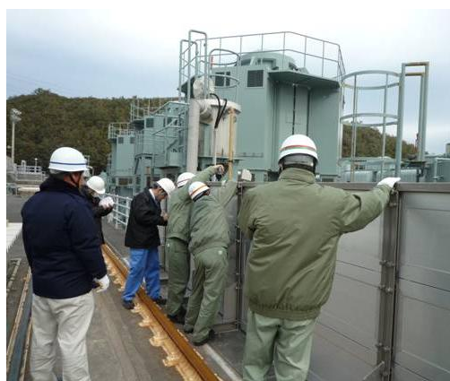
海水取水ポンプエリアへの防水壁点検の様子
