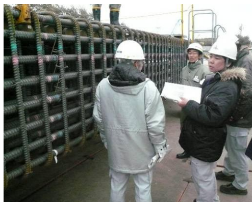
防波壁基礎部(鉄筋かご形状)点検の様子
