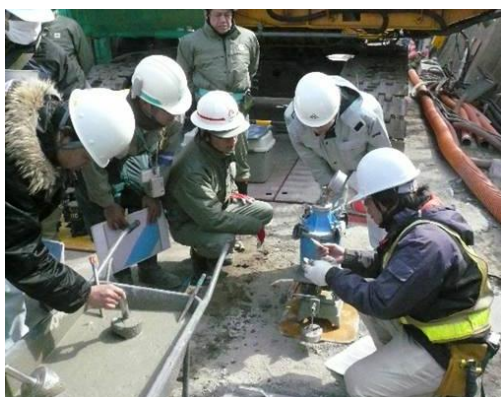
防波壁基礎部(コンクリート品質)点検の様子
