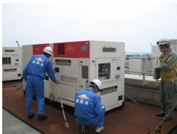
災害対策用発電機点検の様子
