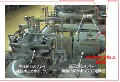
高圧炉心スプレイポンプは非常用炉心冷却系の1系統です。
