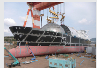
An LNG carrier under construction
