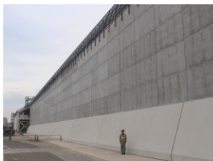
防波壁（高さ:海抜22m）
